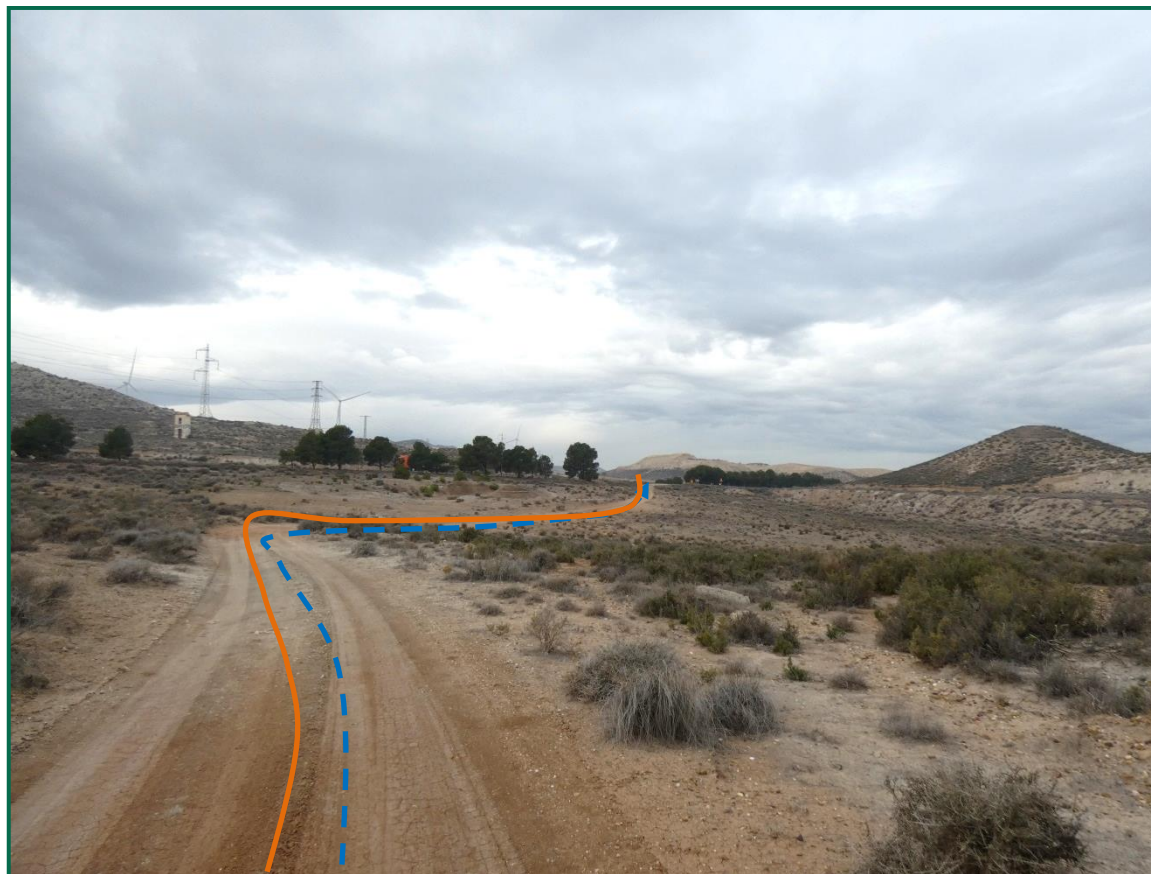
Fotografía 20. Zanja de evacuación del aerogenerador R05.
