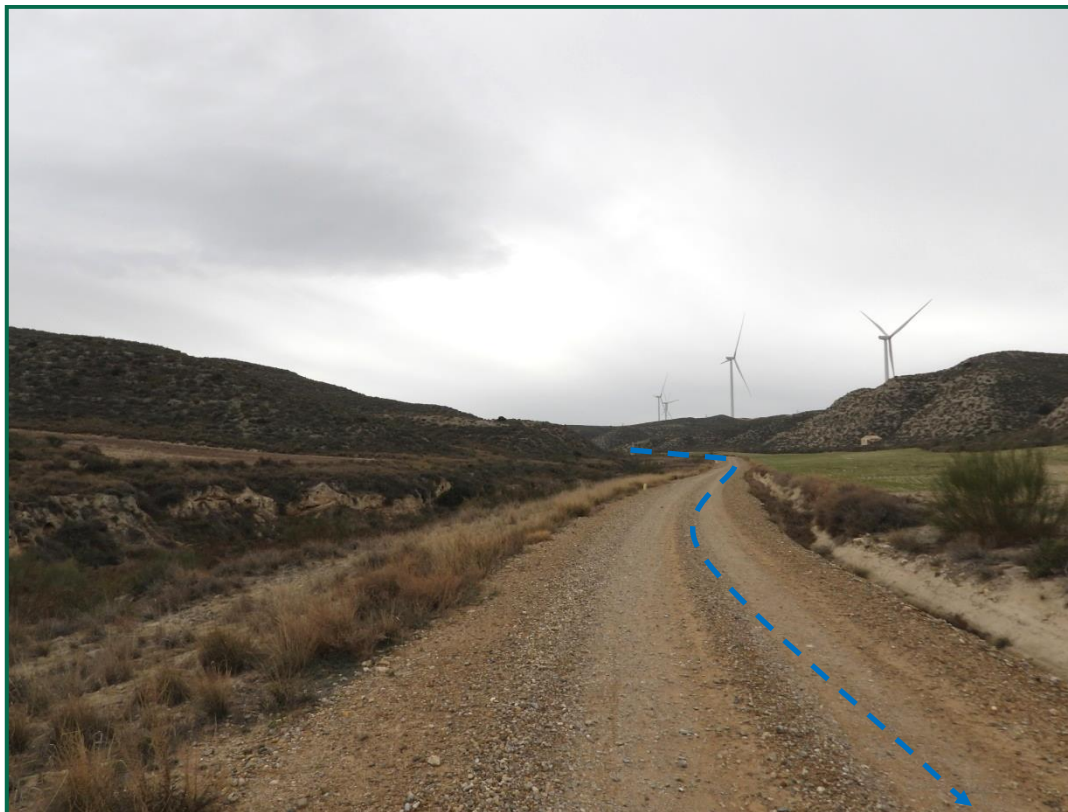
Fotografía 13. Zanja de evacuación de los aerogeneradores R01, R02 Y R03.
