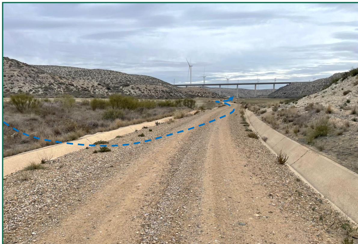
Fotografía 9. Zanja de evacuación de los aerogeneradores R01, R02 Y R03.
