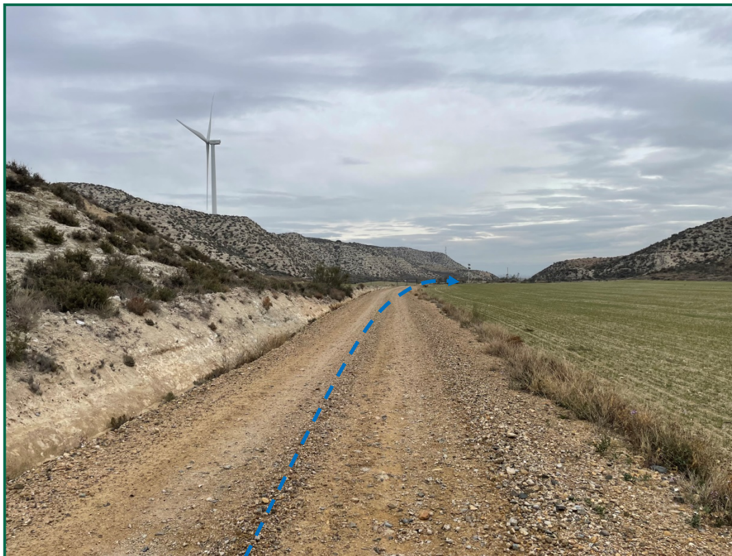
Fotografía 12. Zanja de evacuación de los aerogeneradores R01, R02 Y R03.
