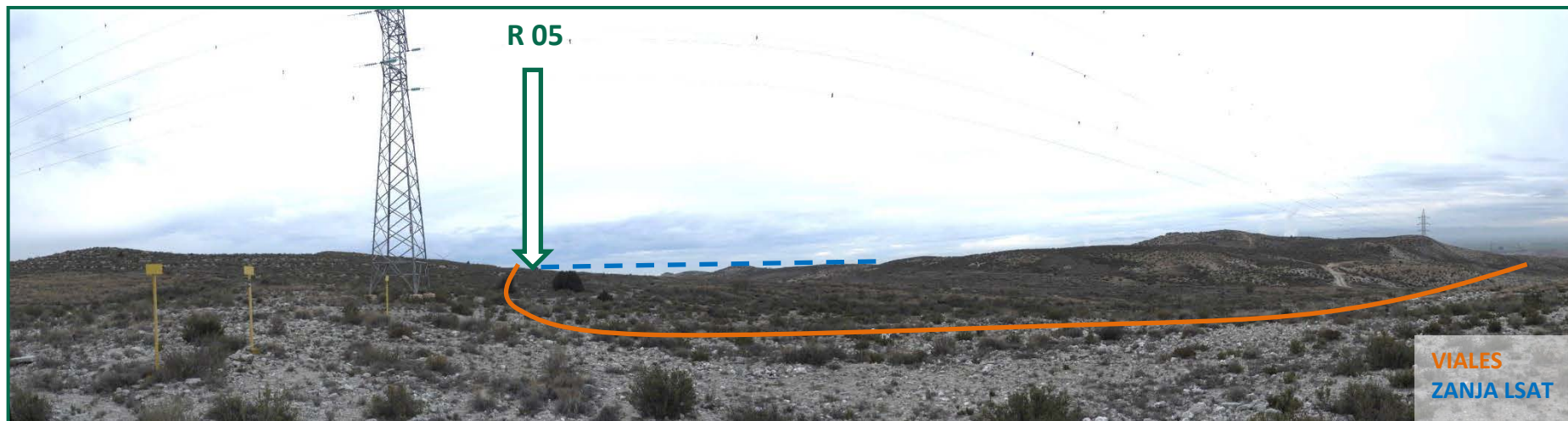
Fotografía 5. Ubicación del aerogenerador R 05 visto desde el sur.
