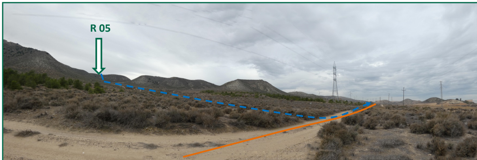
Fotografía 19. Zanja de evacuación del aerogenerador R05.
