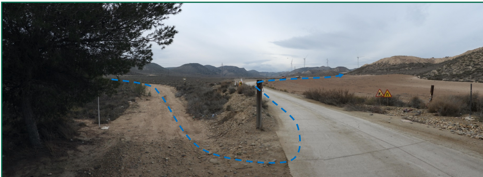
Fotografía 22. Zanja de evacuación de los aerogeneradores R04 y R 05, en dirección a la SET.
