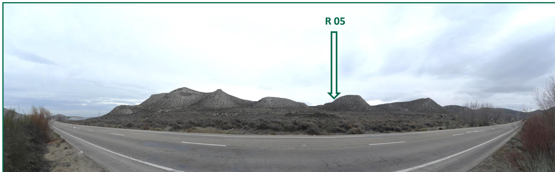
Fotografía 6. Ubicación del aerogenerador R 05 visto desde la carretera A222.
