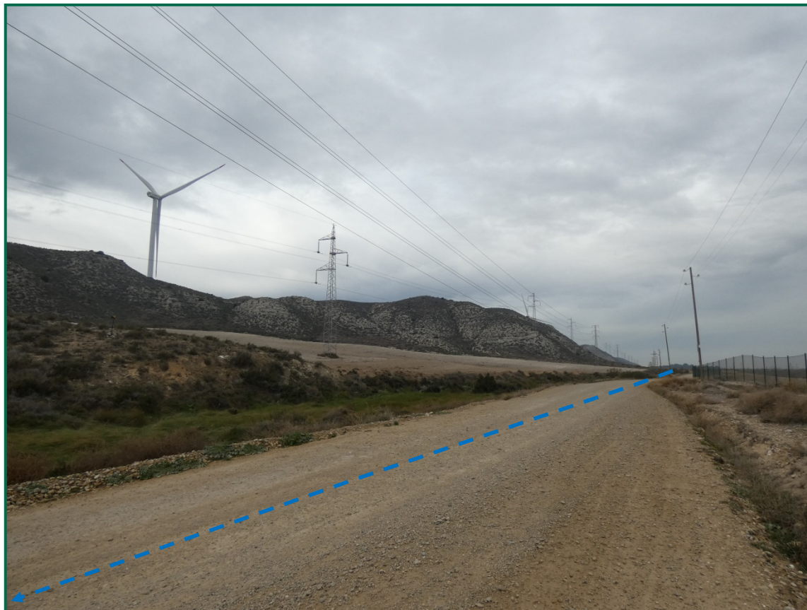
Fotografía 16. Zanja de evacuación de los aerogeneradores R01, R02 Y R03.
