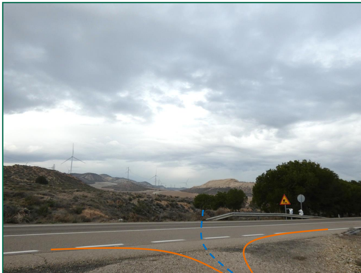
Fotografía 21. Acceso a los aerogeneradores RO-04 Y RO-0. Cruce de la zanja de evacuación con carretera A-222.
