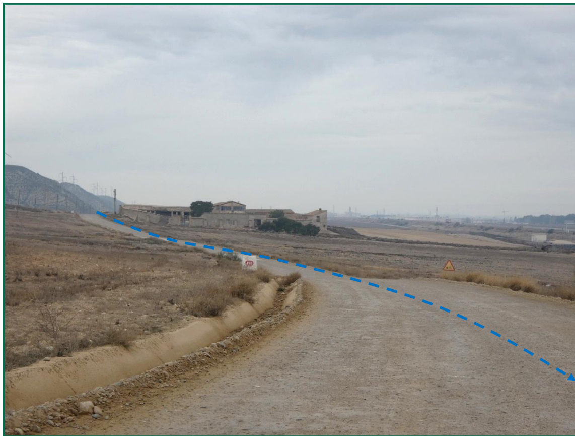
Fotografía 17. Zanja de evacuación de los aerogeneradores R01, R02 Y R03.
