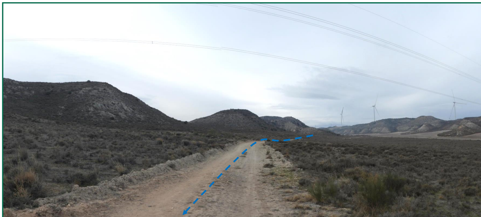
Fotografía 18. Zanja de evacuación del aerogenerador R04.
