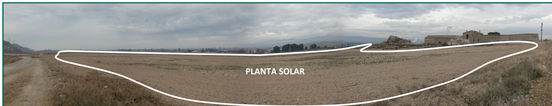
Fotografía 24. PFV Royal, vista desde el sur, zona este.
