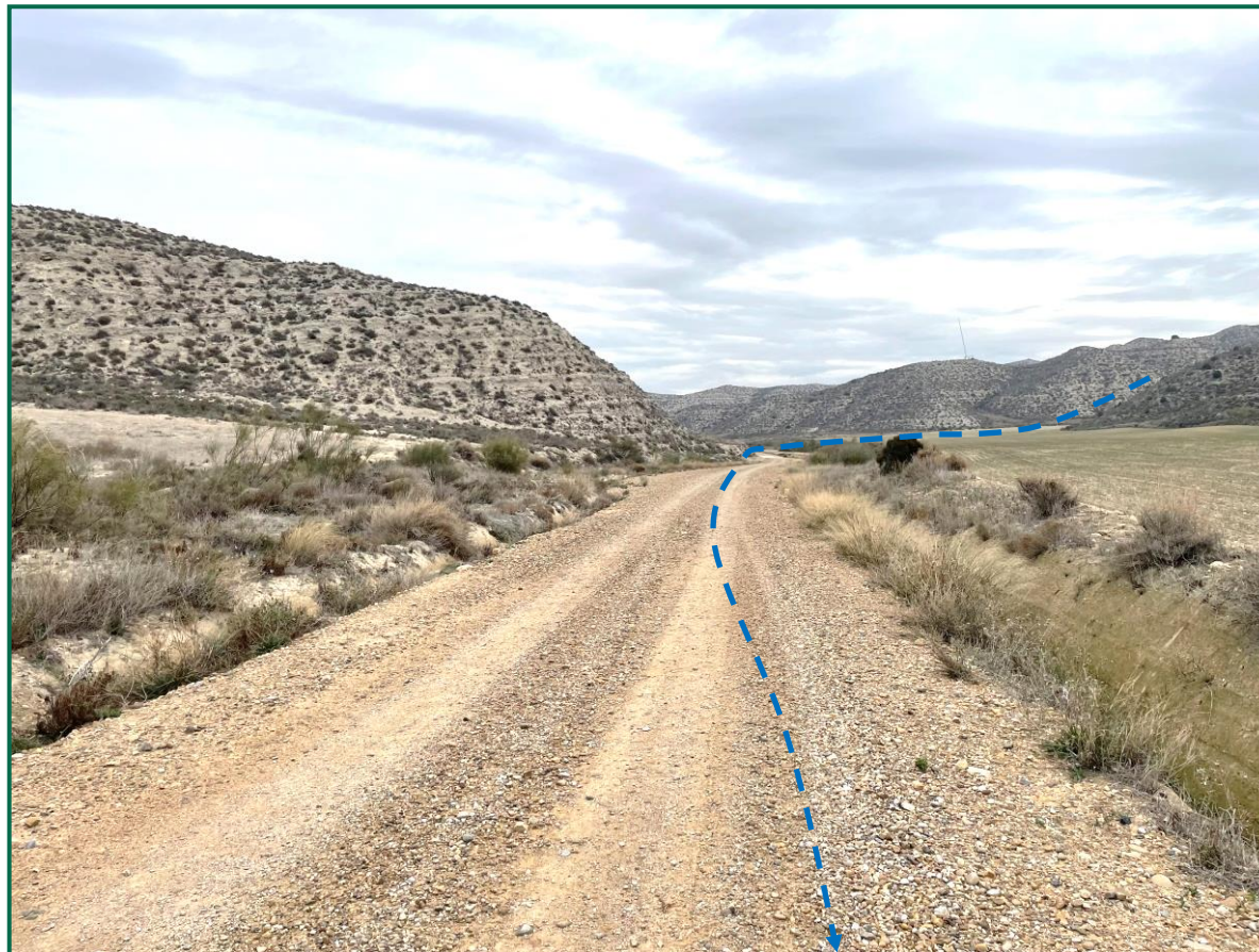
Fotografía 8. Zanja de evacuación de los aerogeneradores R01, R02 Y R03.
