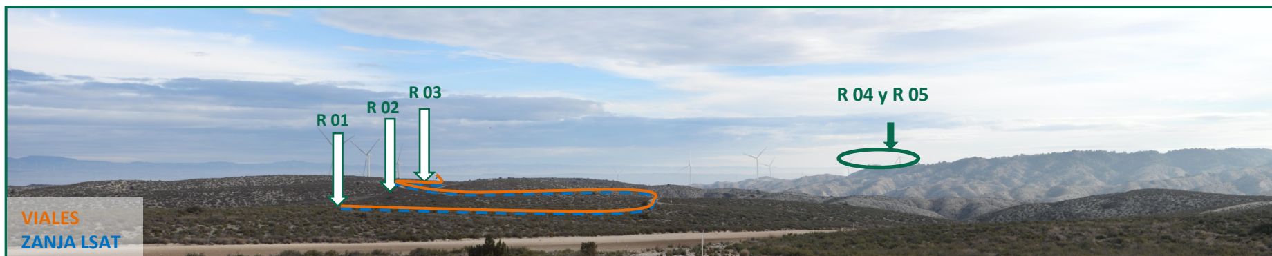
Fotografía 1. Vista general del Parque eólico Royal, en primer plano los aerogeneradores R01, R02 Y R03, a la derecha zona de ubicación de R04 y R05 Al fondo aerogeneradores del Parque eólico ya en funcionamiento “Romerales I”.
