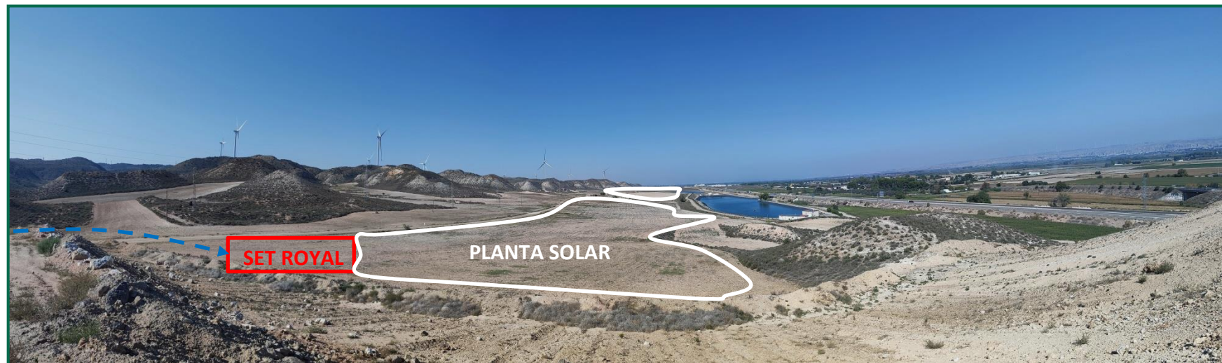
Fotografía 23. Llegada de la Zanja de evacuación de los aerogeneradores SET Royal 45/30kV (objeto de otro proyecto). PFV Royal, vista desde el sur,
