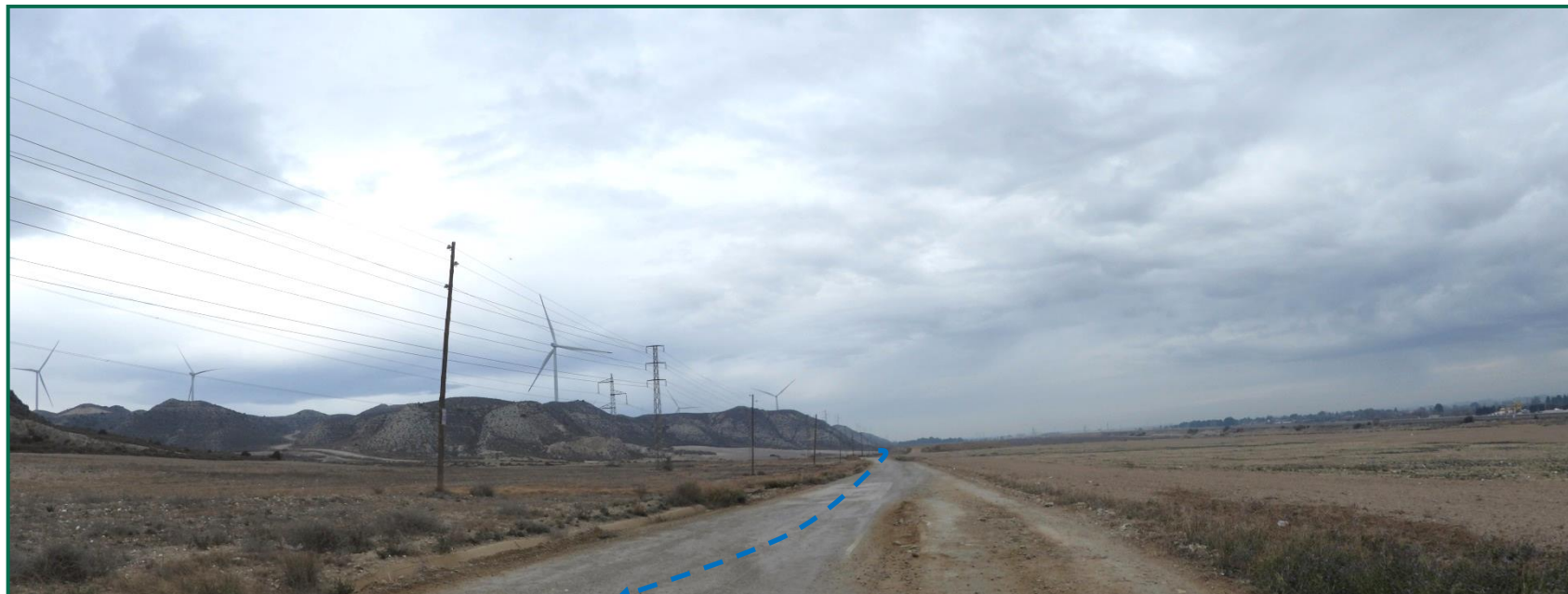
Fotografía 15. Zanja de evacuación de los aerogeneradores R01, R02 Y R03.
