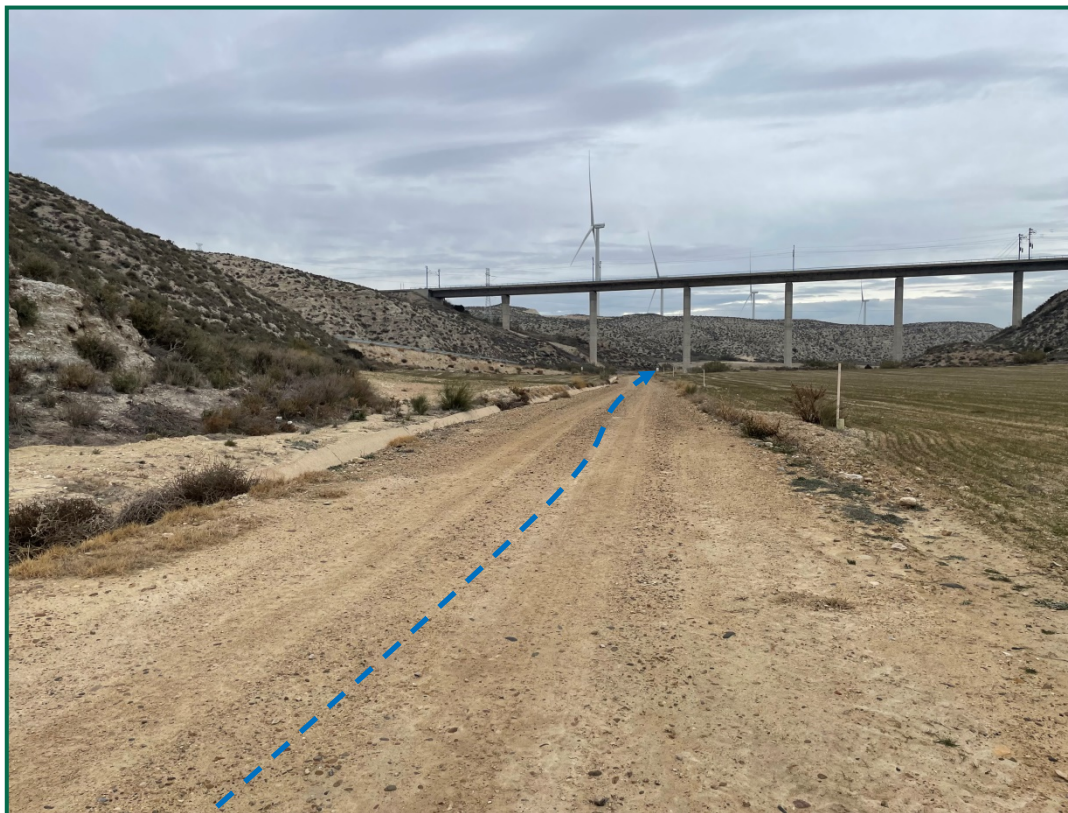
Fotografía 10. Zanja de evacuación de los aerogeneradores R01, R02 Y R03.
